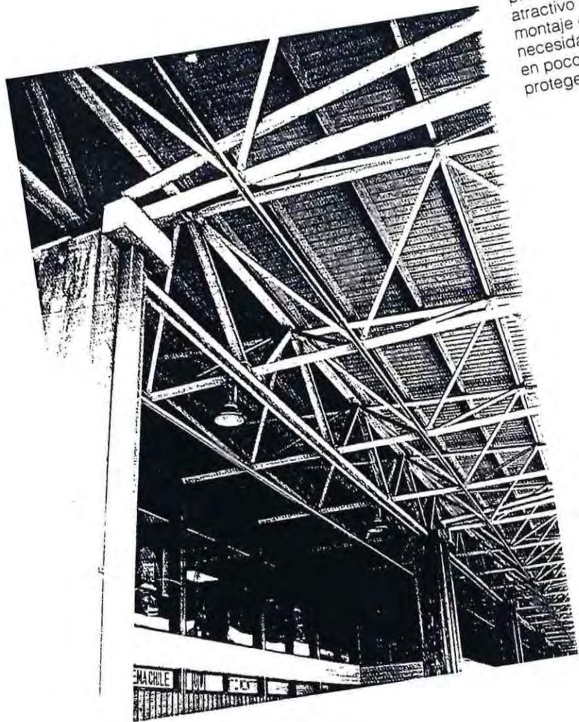
Las características de la zona, con fuertes precipitaciones, hacen particularmente atractivo el uso de acero por la rapidez en el montaje de las construcciones, así como por necesidad de contar con una planta apoyada en pocos puntos y con grandes volados para proteger de la lluvia a los pasajeros.
