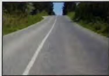
*Figura 3.2 "Solución de camino tipo bichofita y capa asfáltica delgada"*
