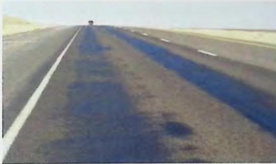
*Figura 2.14 "Exudación en carpeta asfáltica delgada"*
