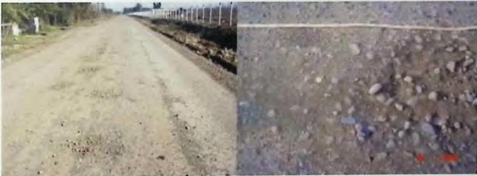
*Figura 2.13- "Desprendimiento del agregado"*
