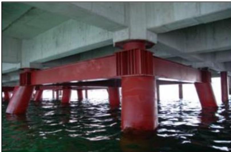
**Figura D.40: Ubicación de aisladores sísmicos del M. Coronel Sur.**
