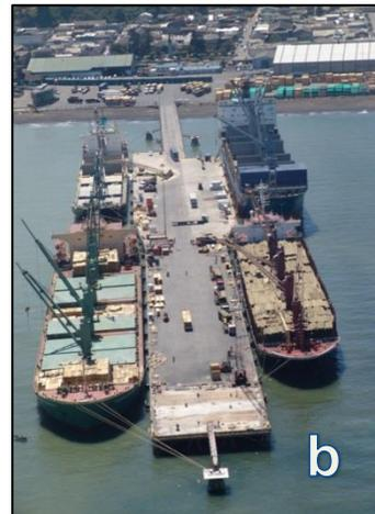
**Figura 3.16: Tipos de muelle: a) Muelle marginal; b) Muelle perpendicular.**
