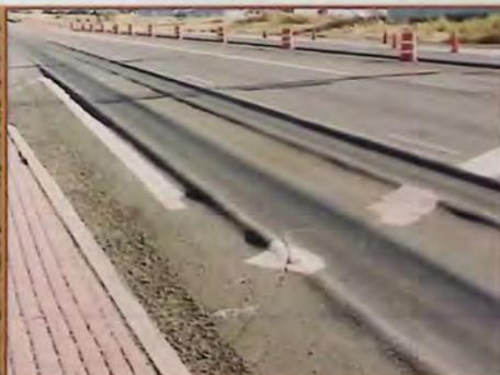
Figura 1.5: Falla por ahuellamiento
