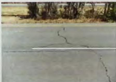
Figura 2.13: Agrietamiento por bajas temperaturas.
