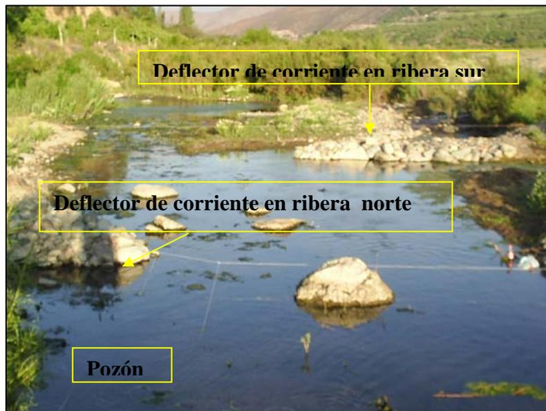
**Figura N° 19:** Ubicación del deflector de corriente en posición alternada y pozo.
