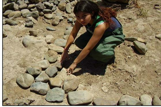
**Figura N° 31 Y N° 32:** Construcción de la primera capa de rodados para el deflector en posición alternada.
