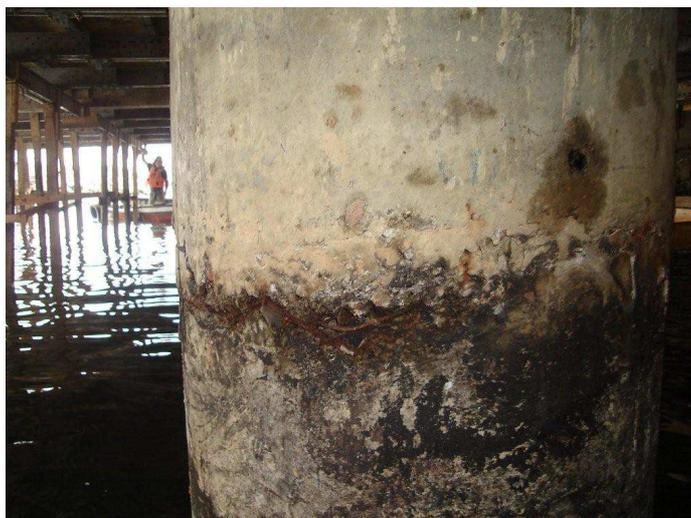
**Figura 9: Columna afectada por "corrosión marina".**
