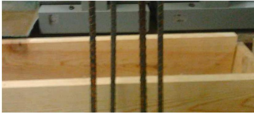
Figura 22: Armadura de acero.
