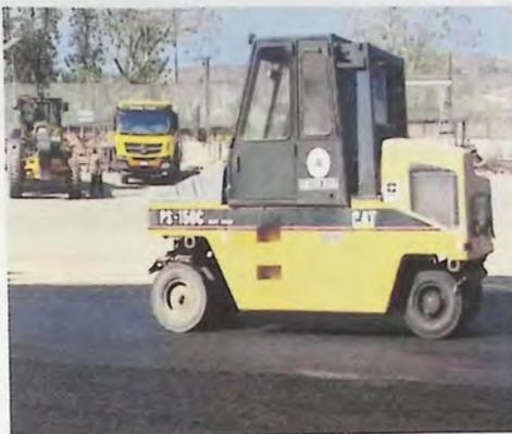
*Figura 5.5 - Compactadora de rodillo de goma finalizando el trabajo*
