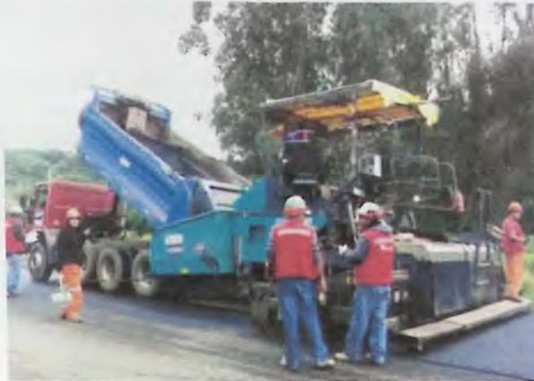
*Figura N°2.7 – Prueba con el uso de un 20% de RAP en mezclas en caliente, Ruta F-50*
