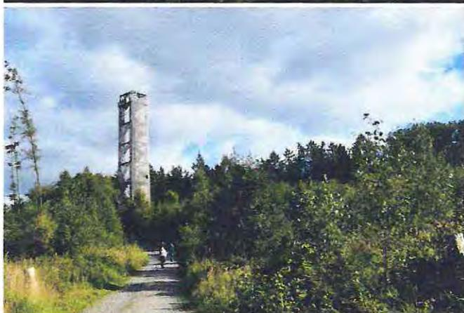
**Fig. 7.36e:** Torre "Möhnesee", Delecke, construcción de acero con madera, altura 42 m, año 2014
