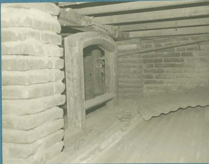
Nº17 detalle del apoyo del entramado de piso en vigas maestras y muchachos
