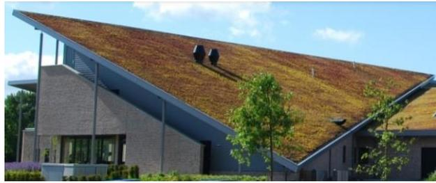
**Ilustración N°11:** Cubierta extensiva
