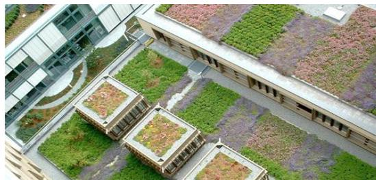
**Ilustración N°12:** Cubierta Semi-intensiva
