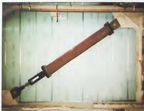
Figura 2.23 - Disposición Diagonal para un dispositivo viscoso [19].
