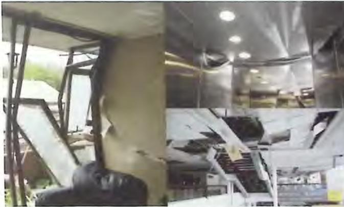
Figura 1.1 - Daños no estructurales generados por terremoto Maule 2010; falla de tabiques y ventanales, falla de ascensores y cielo falso [2].
