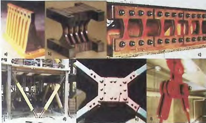
Figura 2.11 - Disipadores activados por desplazamiento a) Tipo TADAS, b) Tipo ADAS, c) Tipo Panel, e) Arriostamiento BRB, f) Fricción de golillas. Fuente: Elaboración propia.
