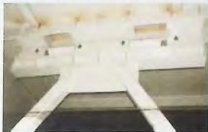
Figura 2.22 – Refuerzo adicional que se emplea en la disposición Chevron [19].
