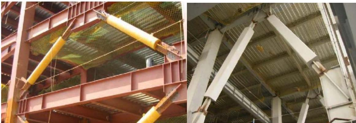
Figura 2.14 - Estructuras de acero equipadas con el sistema de arriostamiento B.R.B. [12].
