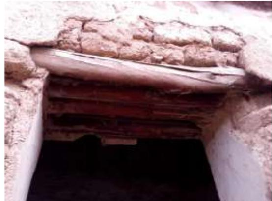
(fig.4.2.42) Imagen Detalle de tuchumbre forrada el tejido de totora. Fuente elaboración propia.
