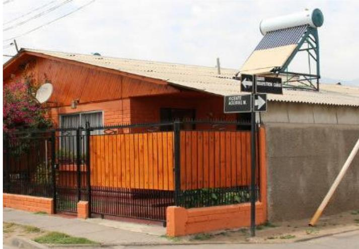
Ilustración 33 CST instalado sobre vivienda, afectando la estética solicitada en Itemizado.
