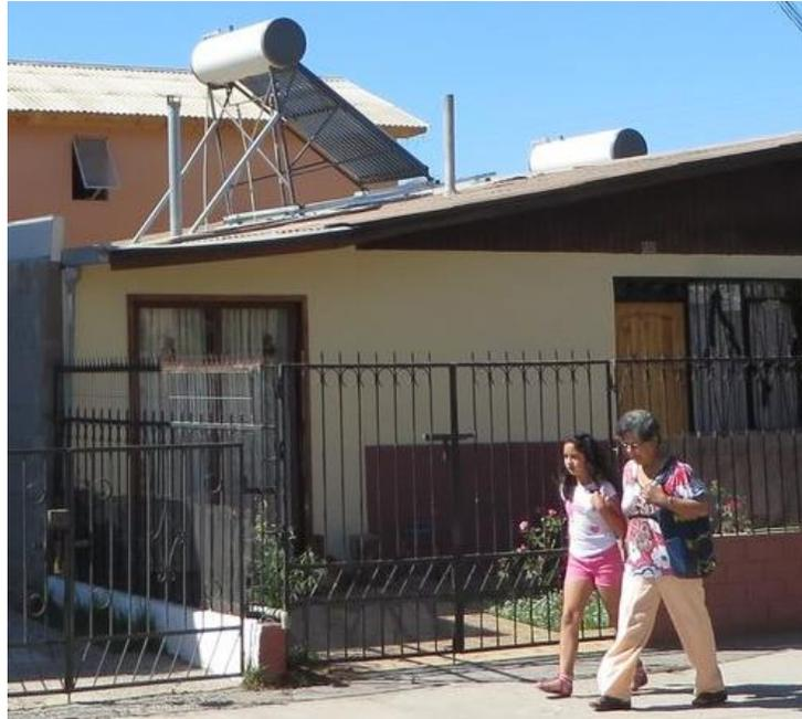
Ilustración 32 Imagen de instalación de CST. Diferencia de sombras.
