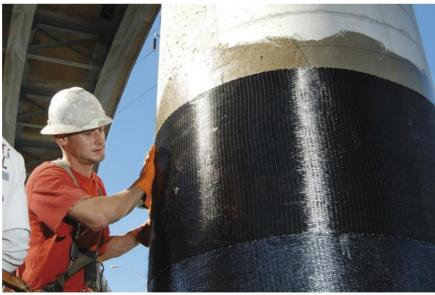
Figuras 2-5:Refuerzo de Pilar circular
