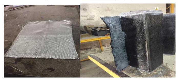
Figuras 3-11:Muestra de corte de tela en Fibra de vidrio y traslapo de fibra
