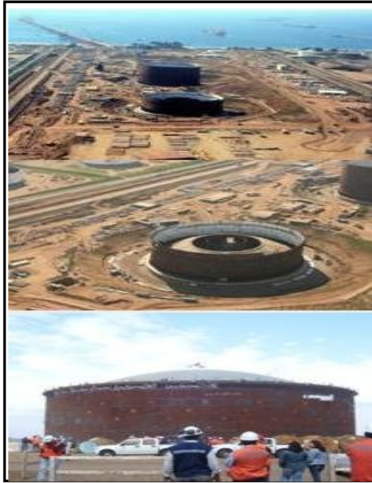
Imagen 5: Fuente Schenker Chile S.A. Departamento de proyectos, construcción planta GNL Quintero.
