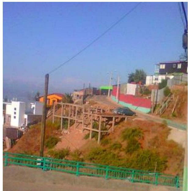
Figura 5: Cimientos de una casa no reconstruida
