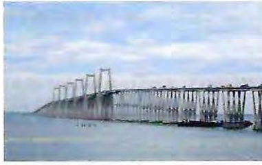
Figura 1.6.: Puente de Maracaibo, Estado de Zulia. Venezuela.
