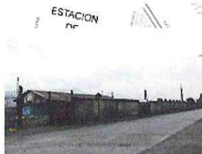
MURO PERIMETRAL ÁREA FERROVIARIA
