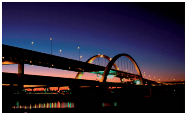
Fig. 3 – Toda la iluminación del puente son Leds de bajo consumo.
