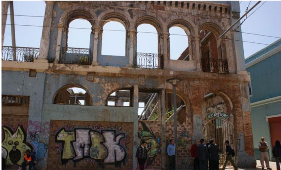
Imagen N°10. 8: “Estado actual de Edificio Subercaseaux”
