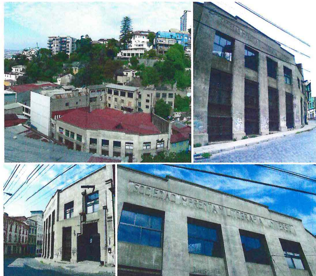
Reconstrucción talleres de la Sociedad Imprenta y Litografía Universo , 1934 Imagen 682 (sup. izq.): Vista del conjunto desde el Cerro Cordillera Imágenes N° 683 a 685 (sup. der. e inf.): Vistas de la fachada por Av. José Tomás Ramos. La ampliación realizada por Otto Anwandter corresponde al último piso, los edificios en el cerro y a la readecuación de los pisos inferiores y la fachada (véase fachada original, pág. 102) Fuente: Tomadas por el alumno, enero 2007 y marzo 2008
