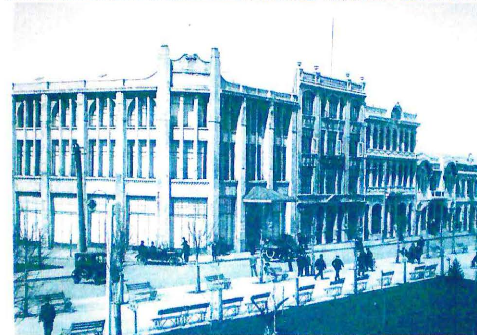
Edificio Casa Comercial Wachsmann & Handelsmann, Av. Ramón Picarte 301 esq. Camilo Henríquez, frente a la Plaza de Armas de Valdivia (actualmente modificado)
