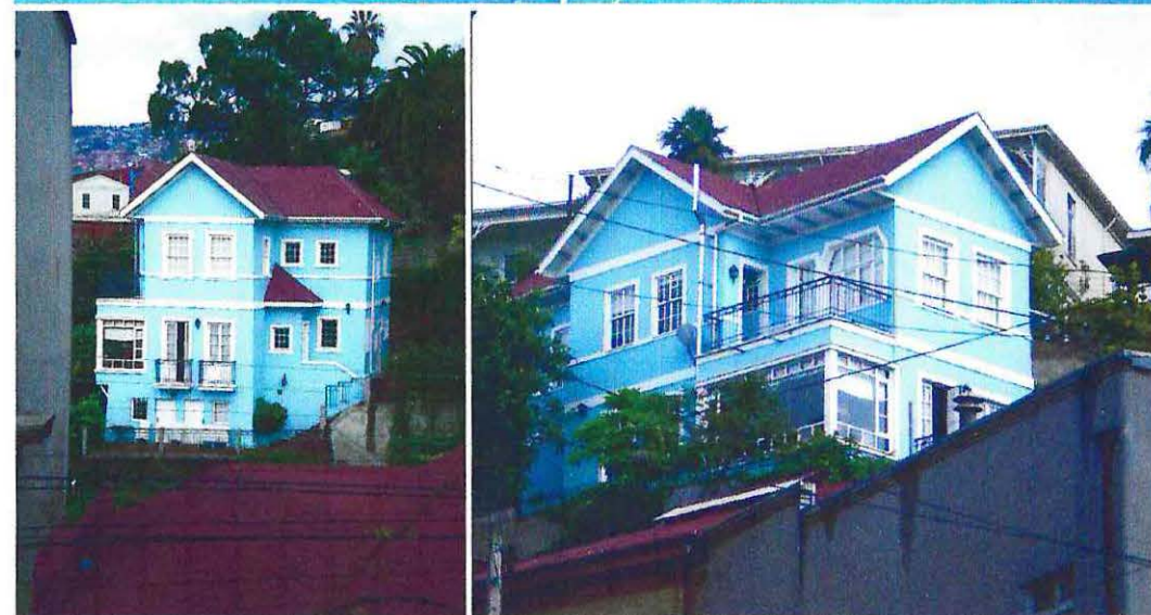
Chalet residencial de don Carl August Rodewald Gildemeister, en calles Santa Isabel y Álvaro Besa 539, Cerro Alegre, 1918 Imágenes N° 735 y 736 (sup.): Fachadas principales, planos originales, Archivos DOM Imágenes N° 737 y 738 (inf.): Vistas recientes desde calles Coronel Urriola y Álvaro Besa Fuente: Tomadas por el alumno, julio 2009
