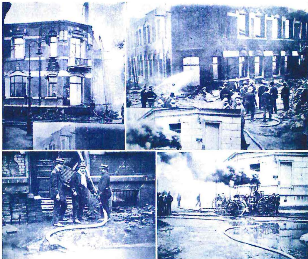
Imágenes N° 511 a 514: Incendio de la primera Fábrica Hucke el día 17 de Noviembre de 1906. Vistas tomadas el día posterior al siniestro, mostrando la ardua labor del cuerpo de bomberos entre los escombros del edificio y la destrucción general del sector causada por el terremoto de Agosto de ese año.
