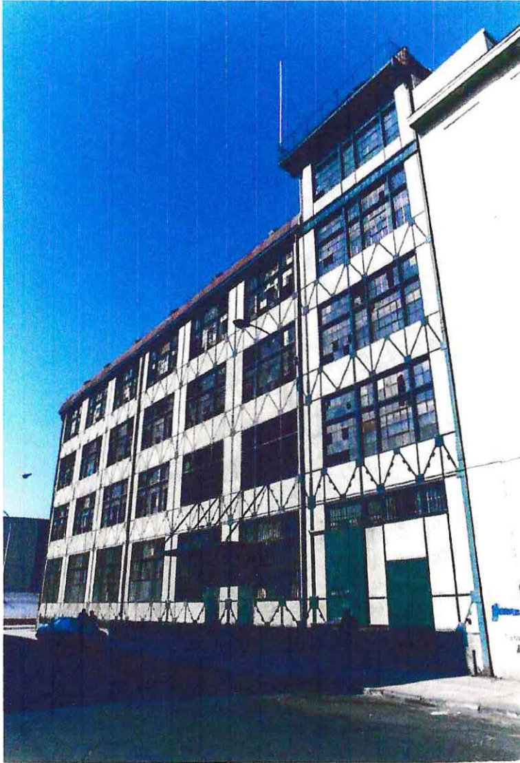
Imagen N° 569: Vista del edificio Huckle en desuso a mediados de la década de 1980. Se observan los accesos de empleados y de carga y descarga, por el 1° nivel de calle Yungay. Las oficinas gerenciales se ubicaban en el 2° piso.
