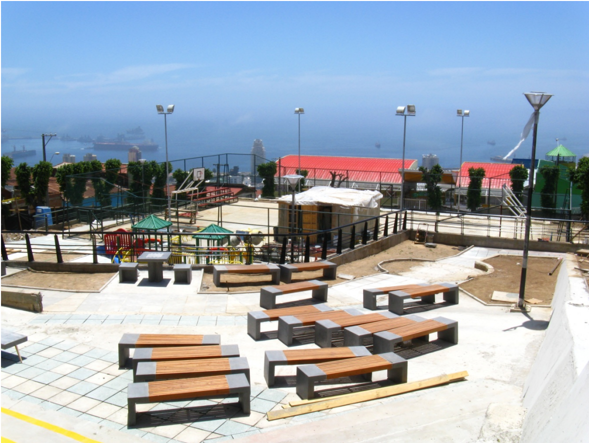
“Mejoramiento Plaza Esmeralda, Programa Recuperación de Barrios”. Elaboración propia.
