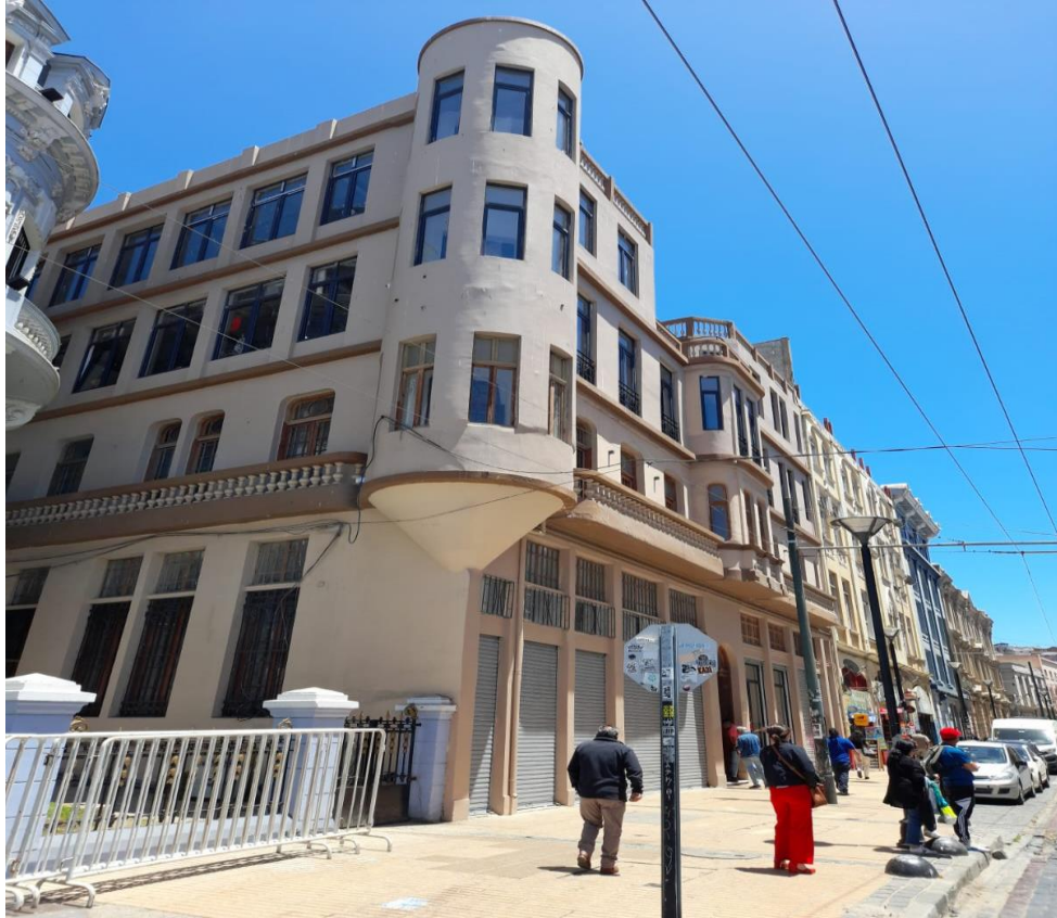
3. Edificio la Nave (1912), ubicado en calle Serrano esquina plaza Sotomayor. Edificio privado arrendado por el municipio, refaccionado y que opera a partir de mediados del año 2023. (foto propia)
