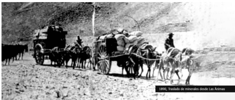
Fotografía N°4 Memoria Chilena. Traslado de minerales desde Las Ánimas, desierto de Atacama. 26
