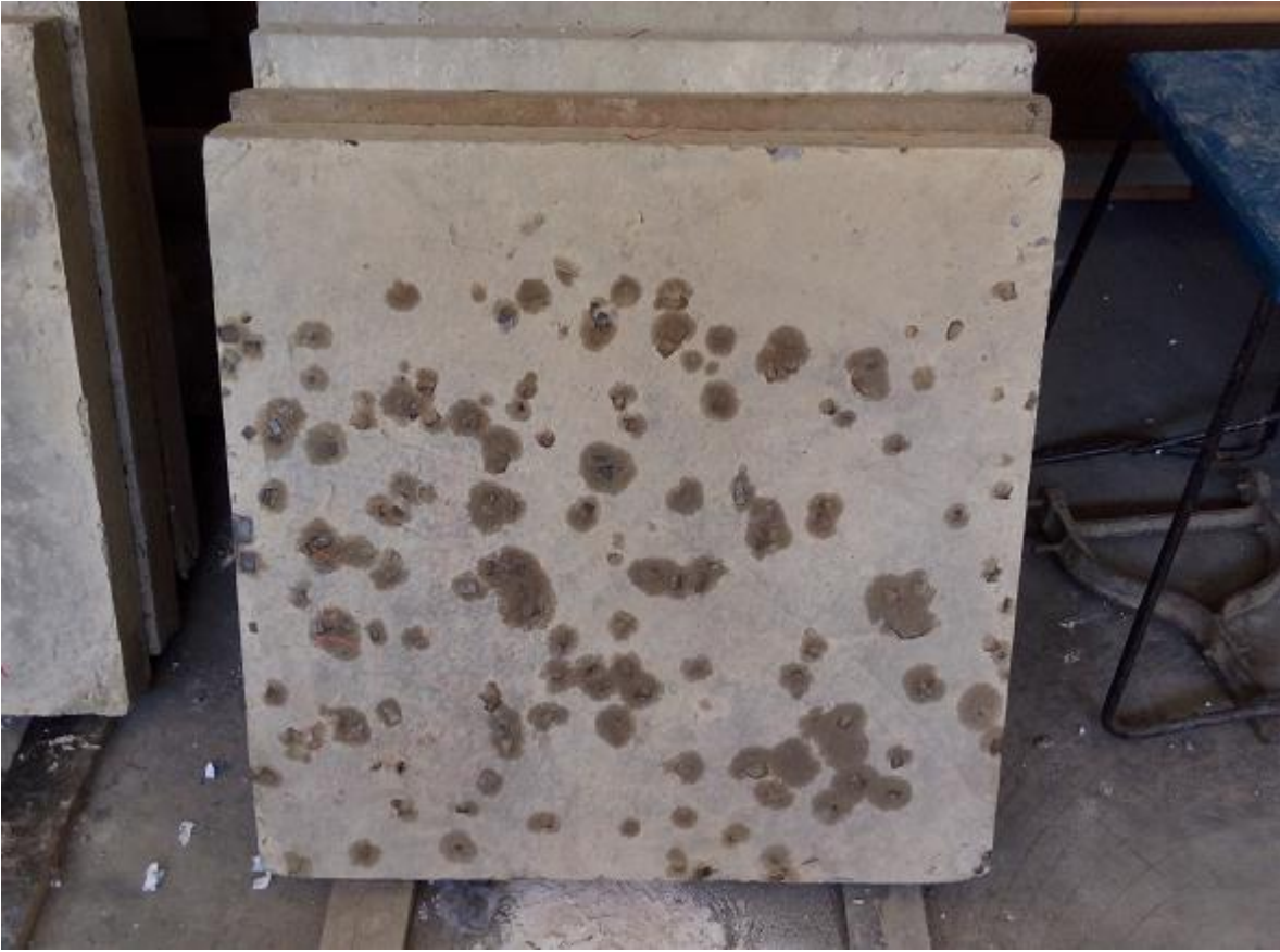
Figura 5.14: Panel con manchas debido a la rotura de cápsulas Fuente: Elaboración propia
