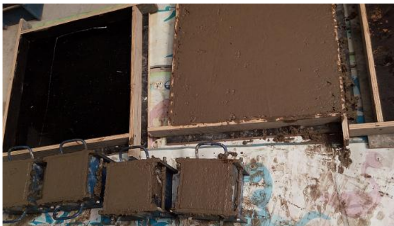
Figura 4.17: llenado de moldes. Fuente: Elaboración propia.
