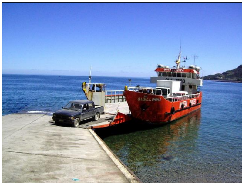
Figura 6 - 7: Rampa de conectividad Caleta La Arena.
