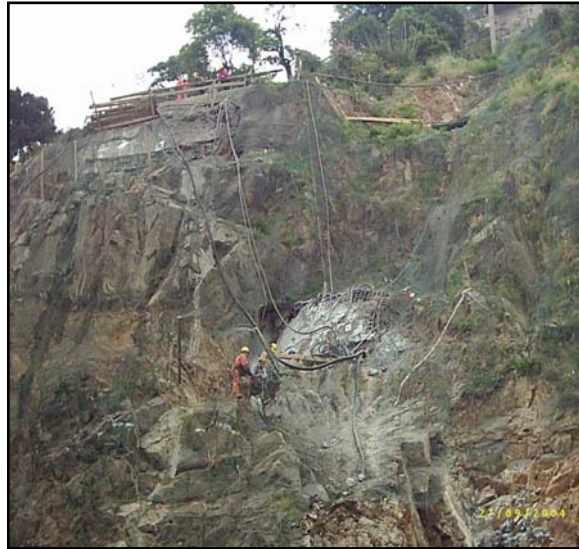
Fotografía N°4: Procesos de Fortificación, en la obra del Túnel de Acceso Puerto.
