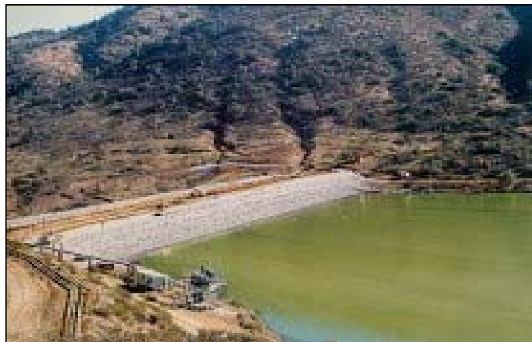
Fotografía N°1: Tranque de Relave Activo o en Uso.
