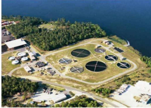
FIGURA 5. Vista aérea de planta de tratamiento de aguas residuales con la tecnología de lodos activos
