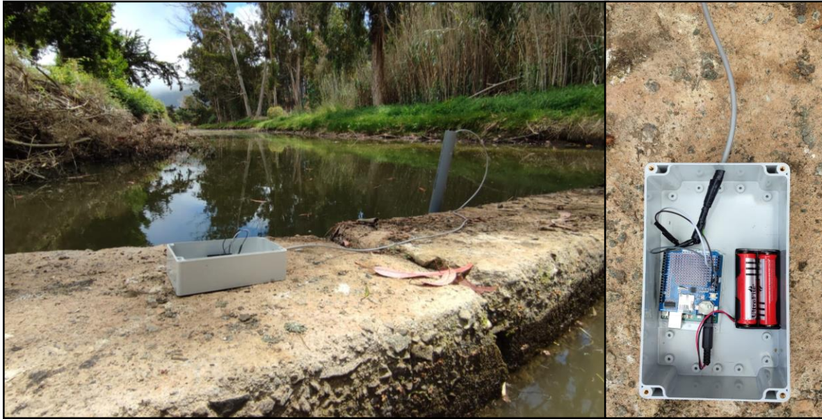
Figura 5.6: Piezómetro instalado en Estero el Jote
