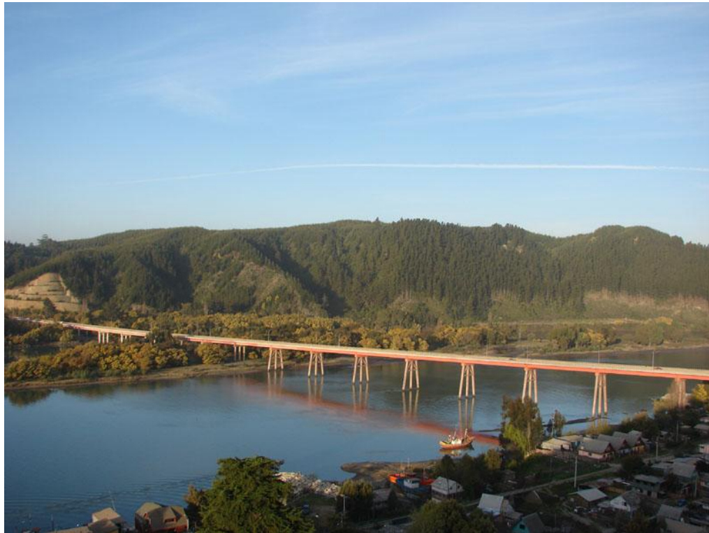
Fotografía n°5. Puente Silva Henríquez.
