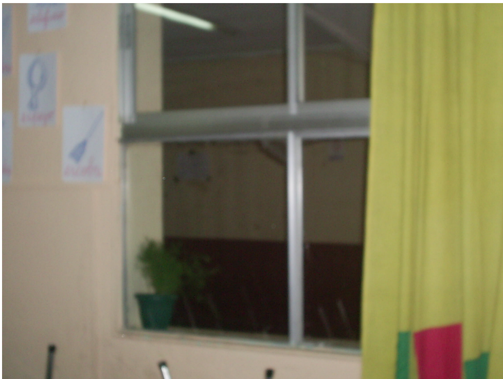
Fig. 4: Ventana sur – poniente.
