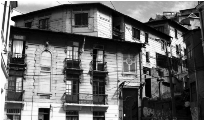
Edificio Favero II, fotografía antes de la restauración (1)
