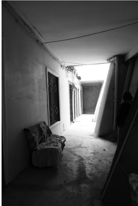
(58) Patio de esparcimiento común del conjunto Favero II, dado por ensanchamiento de área de circulación, adaptada por los propios habitantes.
