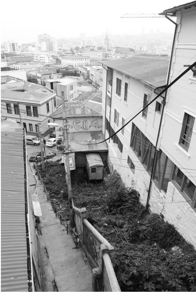
(55) Fotografía tomada desde el puente sobre los carriles del ascensor Florida.
