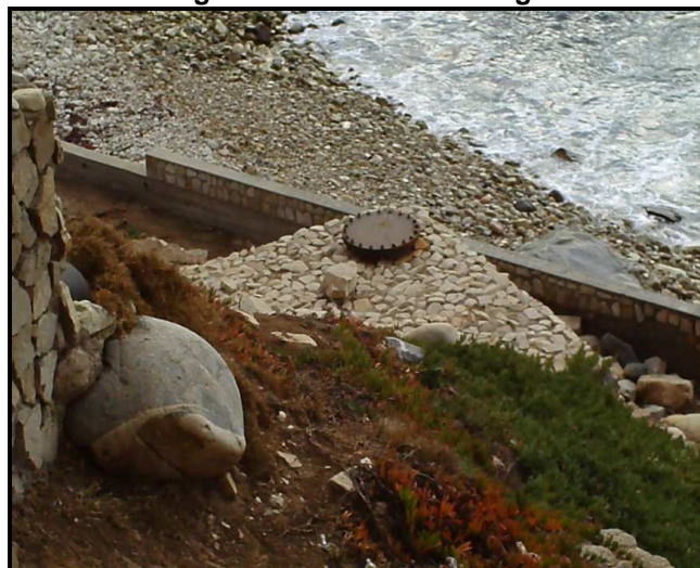
Figura 4-3: Cámara de carga
