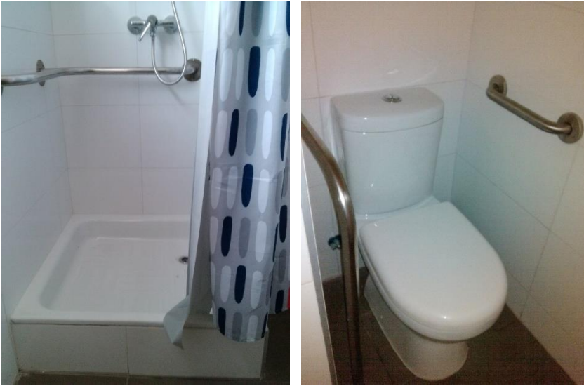
Figura N°a.13: Dependencias del edificio, baño del sauna.
