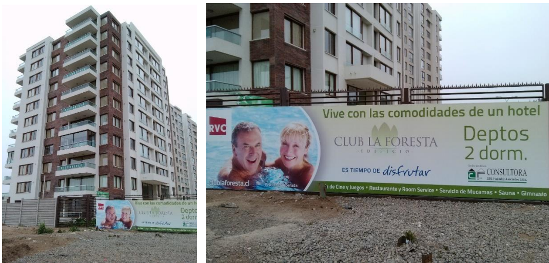
Figura N°a.3: Edificio Club La Foresta, Senior Place.
