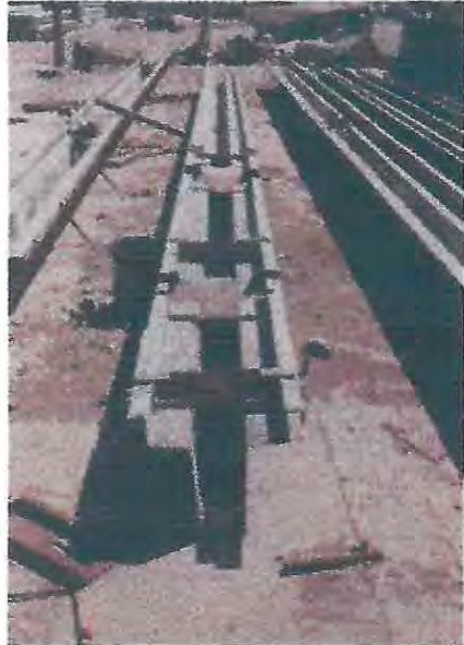
FOTO 18: MOLDAJE VIGUETA
