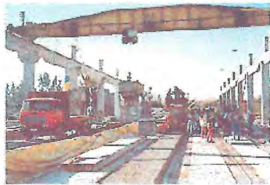
FOTO 12: TRASLADO DEL HORMIGON DESDE EL CAMION, MEDIANTE PUENTE GRÚA DESLIZANTE.
