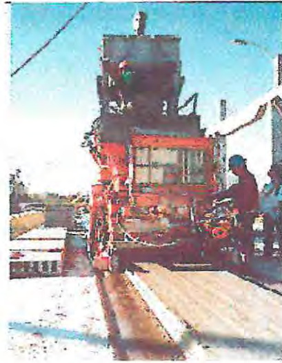
FOTO 11: HORMIGONADO LOSA MEDIANTE MÁQUINA MOLDEADORA
