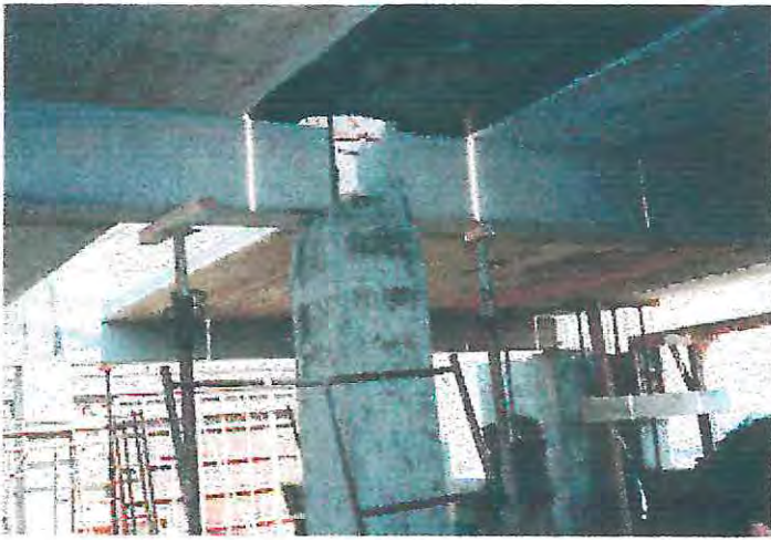
FOTO. 31: ENCUESTRO VIGA- PILAR- LOSA
