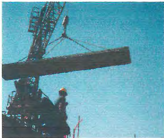
FOTO.26: IZAJE DEL ELEMENTO
