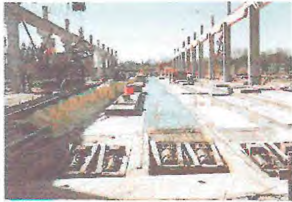
FOTO 1: PREPARACIÓN DE BANCOS PARA PRODUCCIÓN DE LOSAS HUECAS PRETENSADAS.
