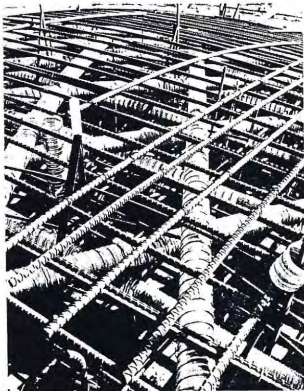
FIG.93: VAINAS Y ALAMBRES DISPUESTOS
