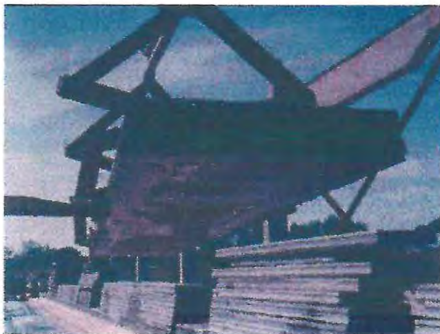
FOTO 16: RETIRO DEL ELEMENTO DE LA PISTA, MEDIANTE EL IZAJE
