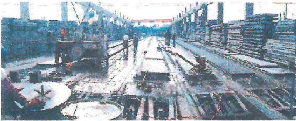
FOTO 3: EXTENSIÓN DE LOS CABLES SOBRE EL BANCO DE PRODUCCIÓN, POSTERIOR A LA COLOCACIÓN DE LOS CABLES EN EL BLOQUE DE ANCLAJE.
