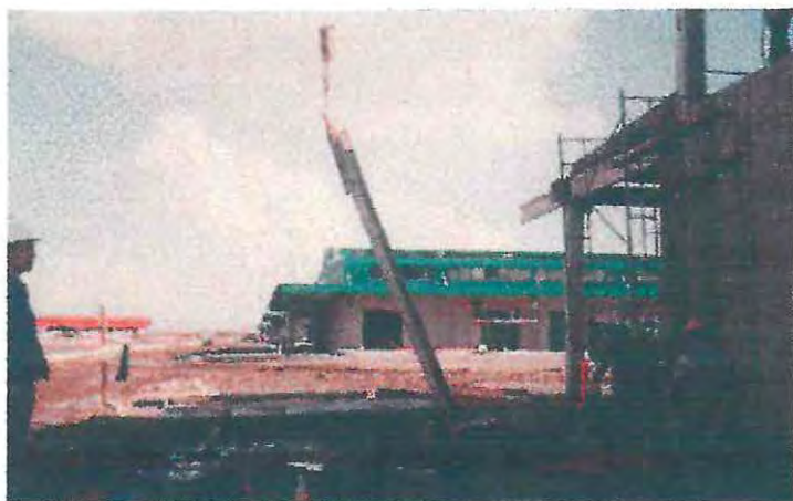
FOTO.39: LEVANTAMIENTO MUROS DE CIERRE
