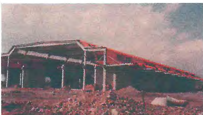
FOTO. 36: VISTA NAVE LATERAL
