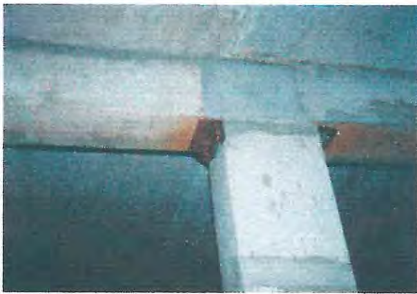
FOTO. 32: REPARACION UNION MEDIANTE EJIONES
