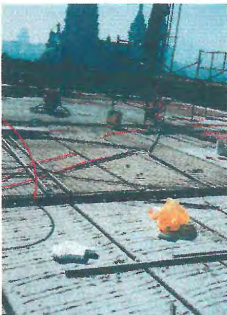
FOTO. 30: PREPARACION SUPERFICIE DE LAS LOSAS PARA LA SOBRELOSA
