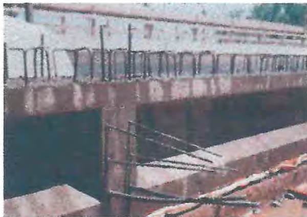
FOTO 24: VISTA LATERAL VIGA PRETENSADA
