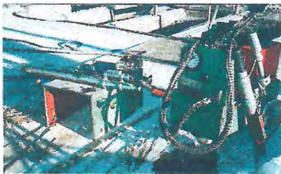
FOTO 5: MÁQUINA DE TESADO COMPUESTA POR GATO HIDRÁULICO Y MANÓMETRO.
