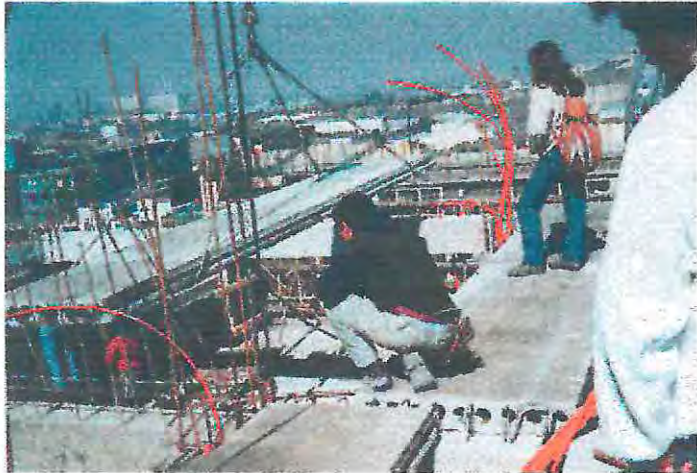
FOTO. 25: MONTAJE LOSA HUECA PRETENSADA
