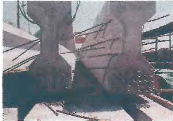
FOTO 23: VISTA VIGA EN SECCION
