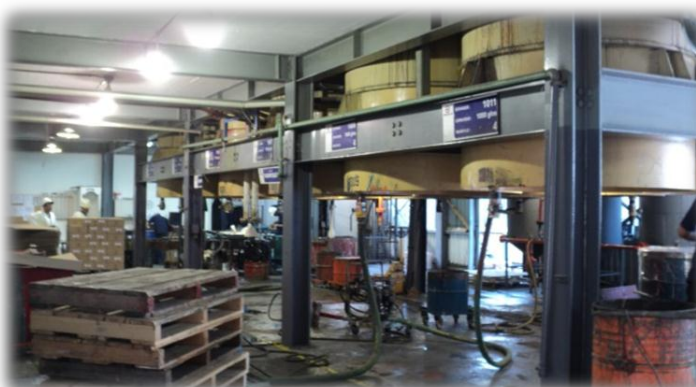
Figura 2.4 Equipo Terminación Planta Molienda.
