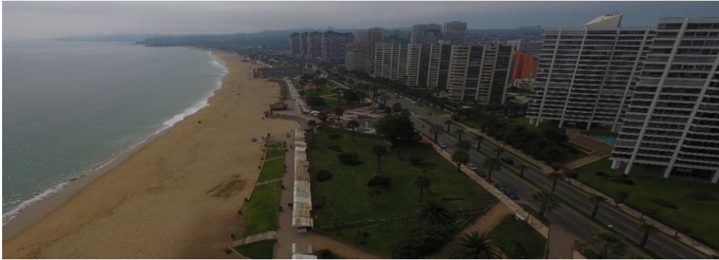
Figura 4- 5: Tipología constructiva, áreas verdes
