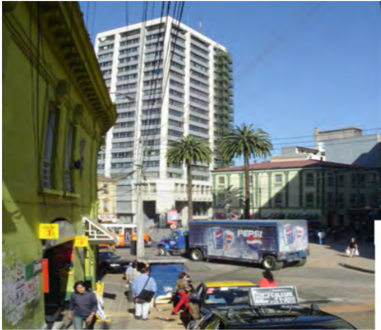
FIGURA Nº 9 Desde Almirante Montt la percepción del edificio esta dado por las fachada principal y por la fachada de calle Condell. El contraste de altura con respecto al edificio de la Intendencia Regional que rompe con la altura de los edificios que conforman la contención perimetral de la plaza
