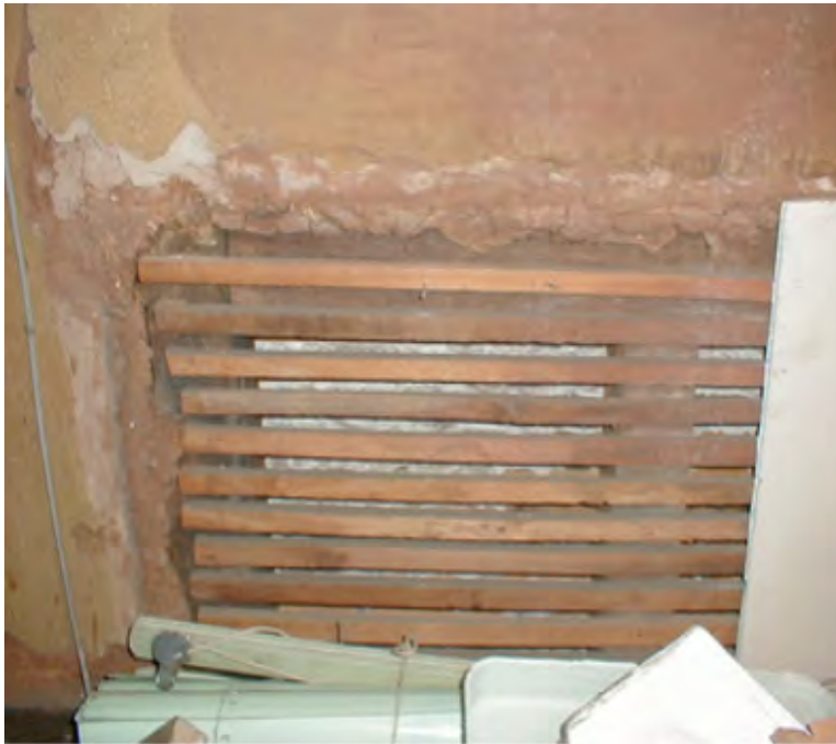
FIGURA Nº 44 Detalle de un muro del tercer nivel que deja a la vista el sistema de construcción de los muros de madera los cuales eran rellenos de adobillo, como material aislante.
