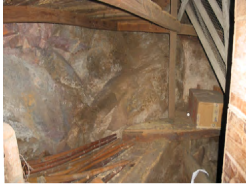
FIGURA Nº 40 Inédito, roca natural de mar que se encuentra en un extremo de la bodega nº 2 de la farmacia, donde parte de la estructura del edificio se asienta sobre ella.
