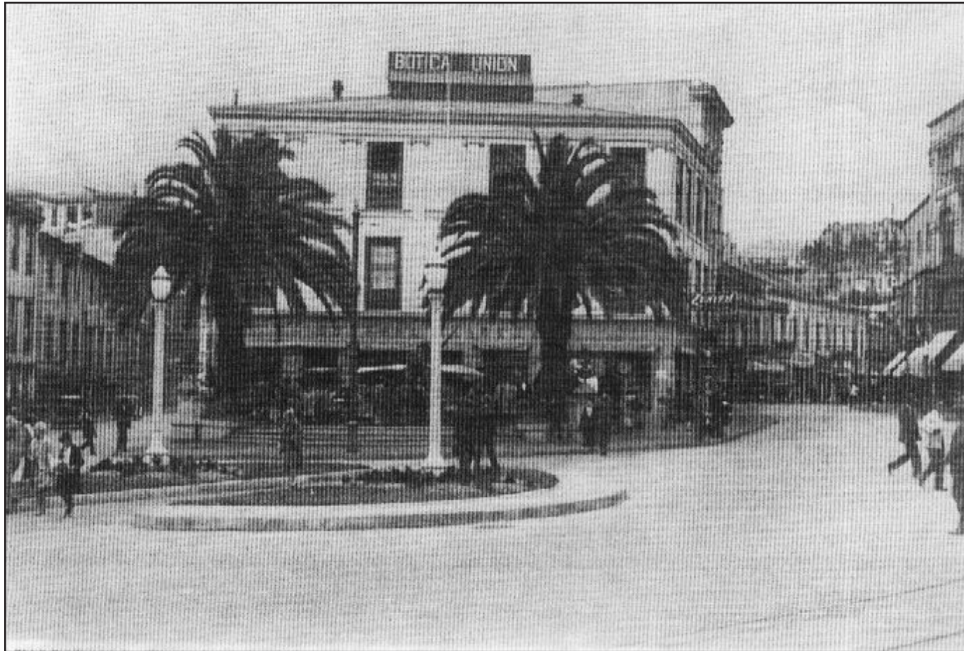
FIGURA Nº 58 Edificio Ivens en 1948 aprox. Fuente: Donación Librería Ivens.
