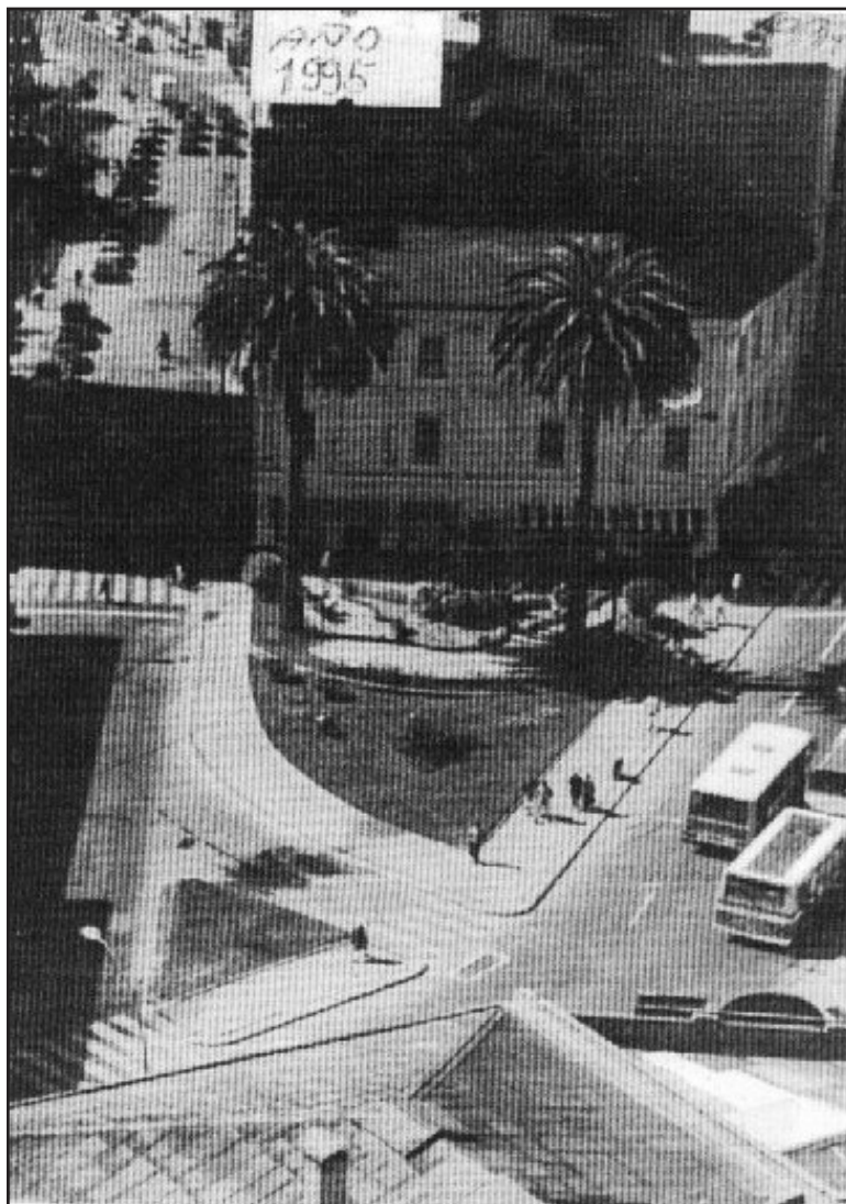
FIGURA Nº 60 Edificio Ivens en 1995. Fuente: Donación Librería Ivens.
