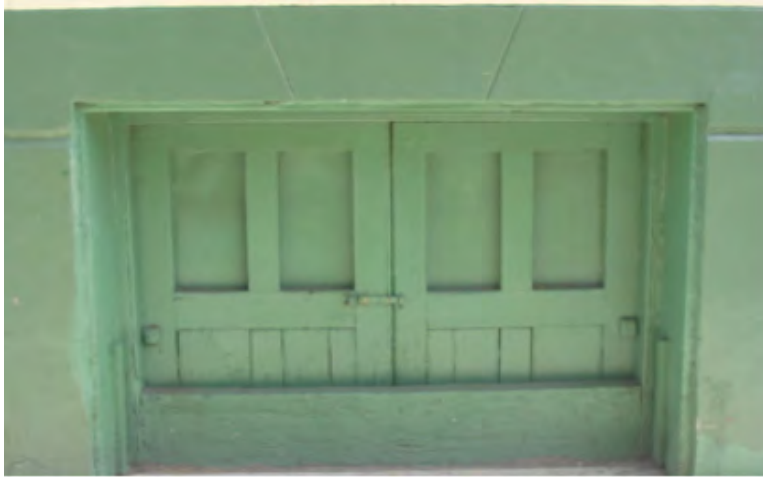
FIGURA N° 21 Puerta de madera de dos hojas del acceso desde calle O'Higgins hacia el nivel de zócalo, tiene un ancho de 1.5 mt por 1.3 mt de alto. Actualmente se encuentran fuera de uso.
