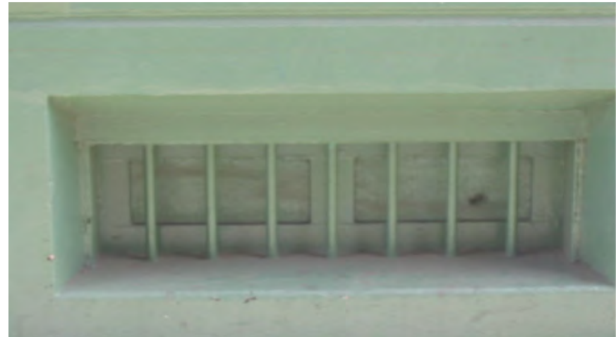
FIGURA N° 22 Ventana de iluminación y ventilación del nivel de zócalo por calle O'Higgins, dado su dimensión es de 1.3 mt de ancho por 0.5 mt de alto, posee barras de fierro de 2 cm de diámetro. Actualmente esta totalmente cubierta, no permite el ingreso de iluminación ni de ventilación hacia el interior.
