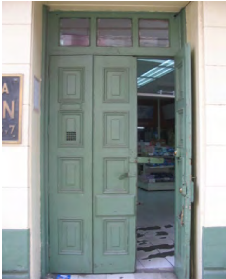
FIGURA N° 20 Puerta de madera de Pino Oregón de tres hojas de calle Condell, tiene un ancho 1.4mt de por 3.1mt de alto. en su extremo superior posee vidrio dejando ingresar luz al interior de la farmacia.
