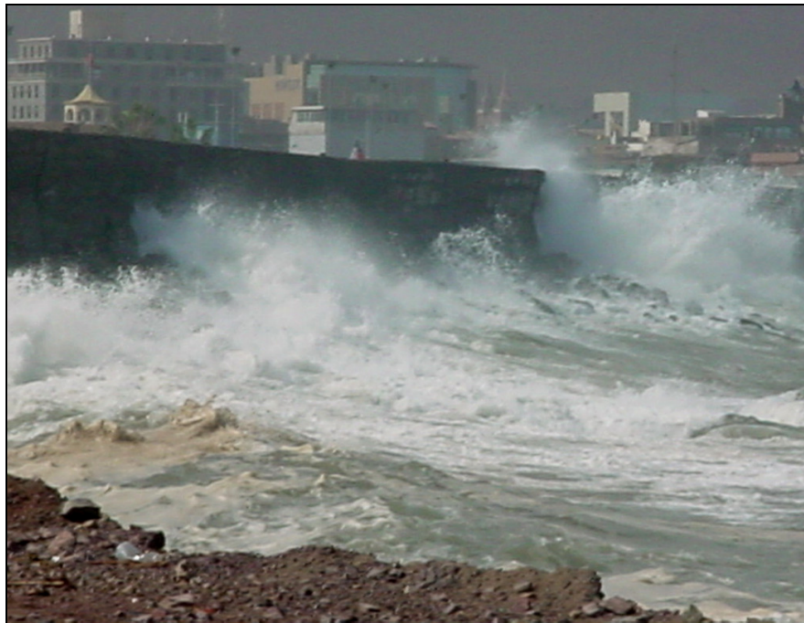
Figura 4-10: Imágenes de sobrepaso en sector de acceso a la Ex-Isla Serrano.
