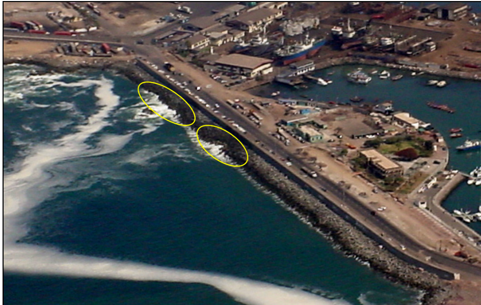
Figura 4-9: Secciones con fallo estructural reportadas por el INH.
