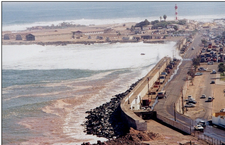
Figura 4-8: Imágenes de sobrepaso en sector de acceso a la Ex-Isla Serrano.
