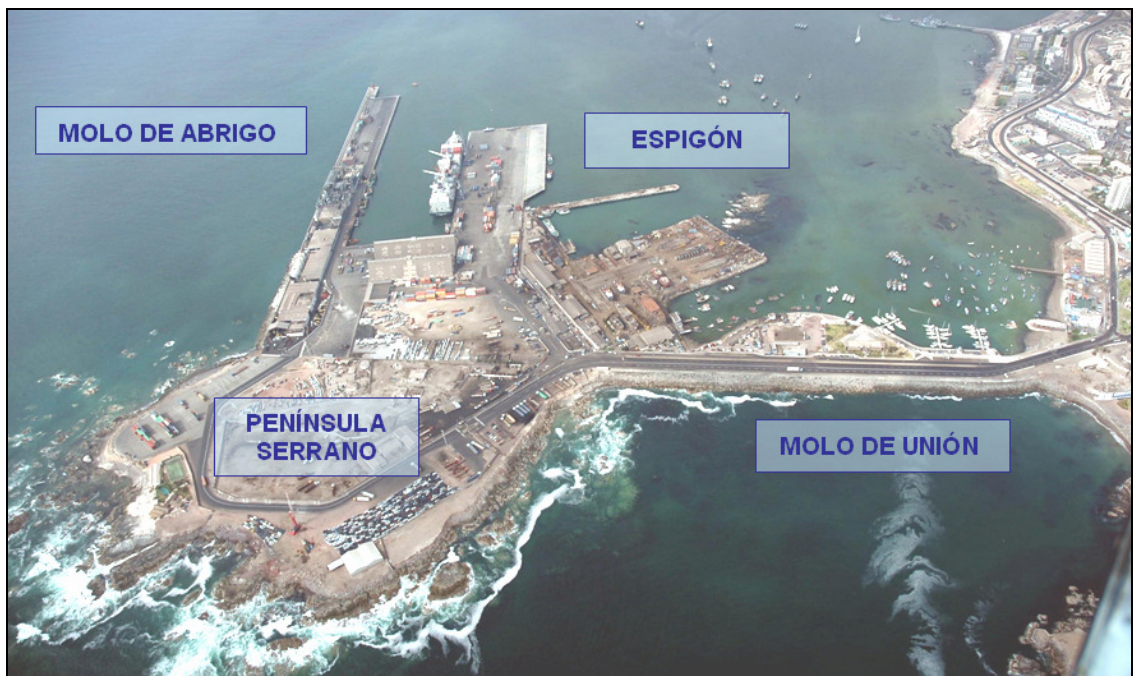
Figura 3-1: Vista general del puerto de Iquique.
