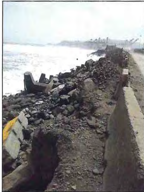
Figura 6-3 Fotografía del extremo sur de la zona del proyecto. Fecha 16/11/2013
