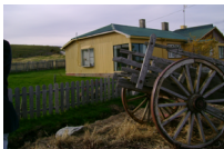
Modificación a vivienda, manteniendo su volumetría original
