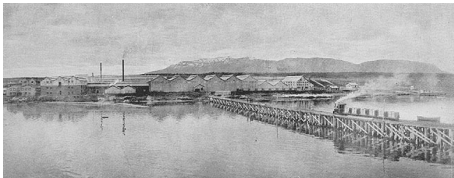
VISTA PANORÁMICA DONDE SE APRECIA EL TREN DE CARGA CIRCULAR SOBRE EL MUELLE, 1928
