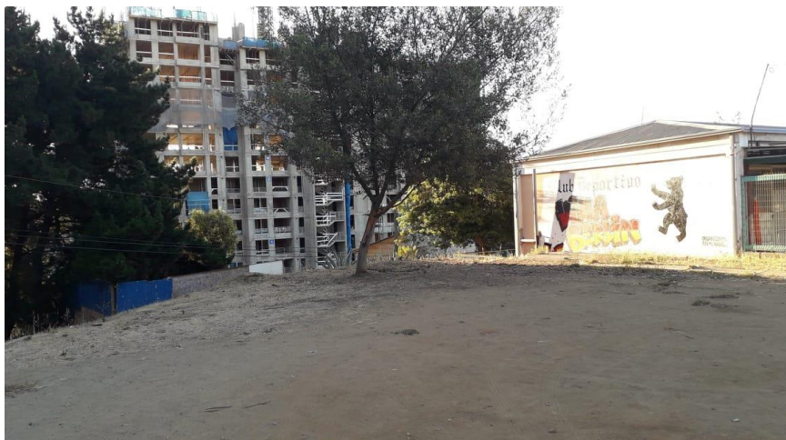
Imagen 20: Casa Comunal colindante al edificio Alto Placeres. Fuente: Elaboración propia.
