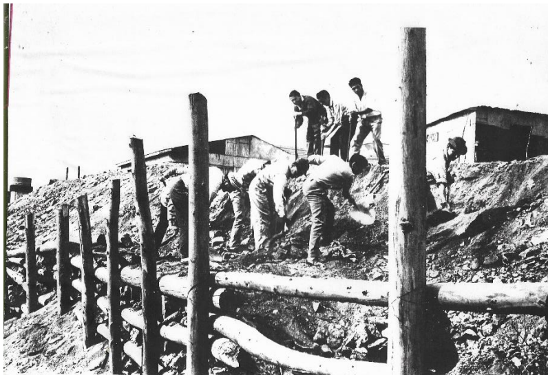
Imagen 7: Pobladores construyendo sus hogares, Villa Berlín, cerro Los Placeres
