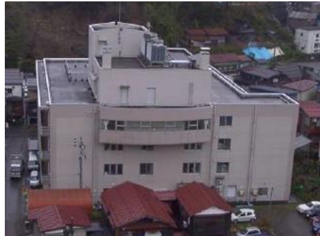
Figura 2.14. Edificio de hormigón armado de la ciudad de Ojiya
