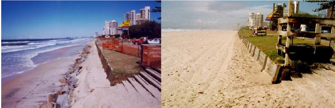
Figura 23: Mejora de Línea de costa, Narrowneck, Australia.
