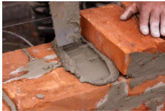
Figura 2.6. Aplicación de mortero de pega.
