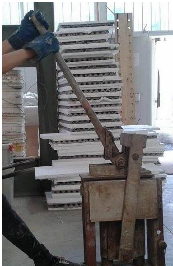
Figura 4.10. Compactación del ladrillo.
