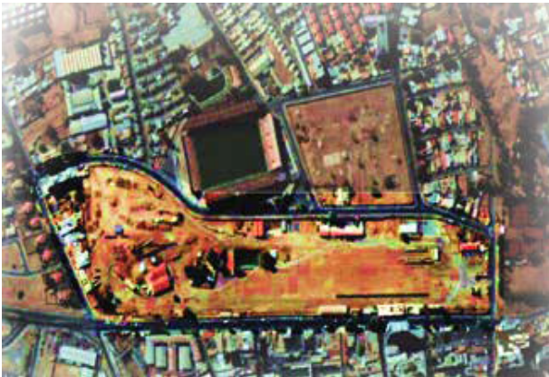
Fotografía aérea ex estación de ferrocarriles
