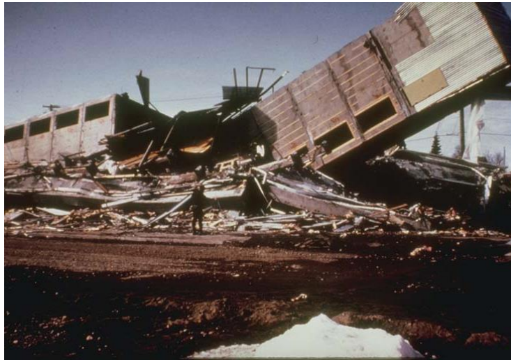
Figura 65: Daños presentados luego del terremoto de 1964, Alaska.
