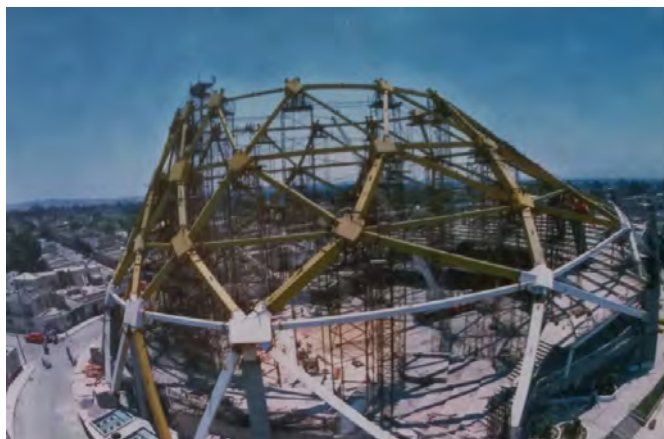
Ilustración 18. Colocación de la estructura metálica 23
