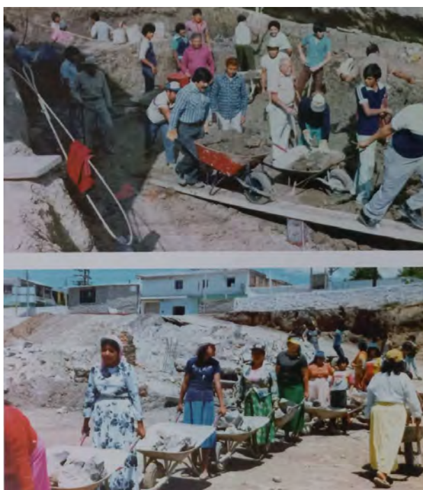
Ilustración 17. Trabajo de los hermanos en la construcción del templo sede internacional, Hermosa Provincia 22
