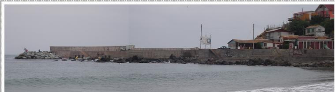
Figura Nº 30: Molo de Abrigo Caleta Pichicuy
